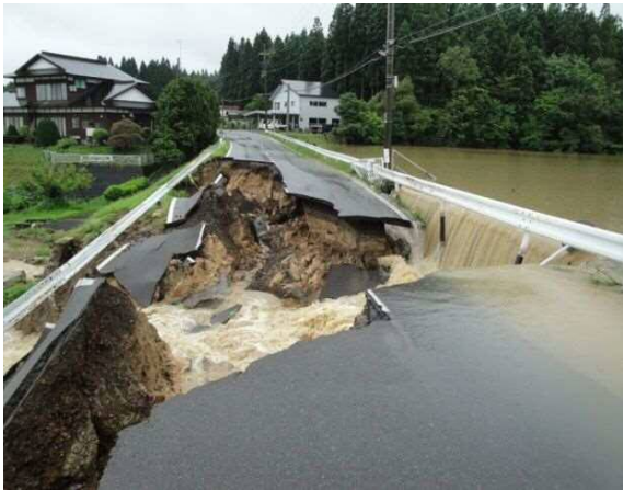
戸賀沢2号ため池決壊 【秋田市(旧雄和町戸米沢)】
